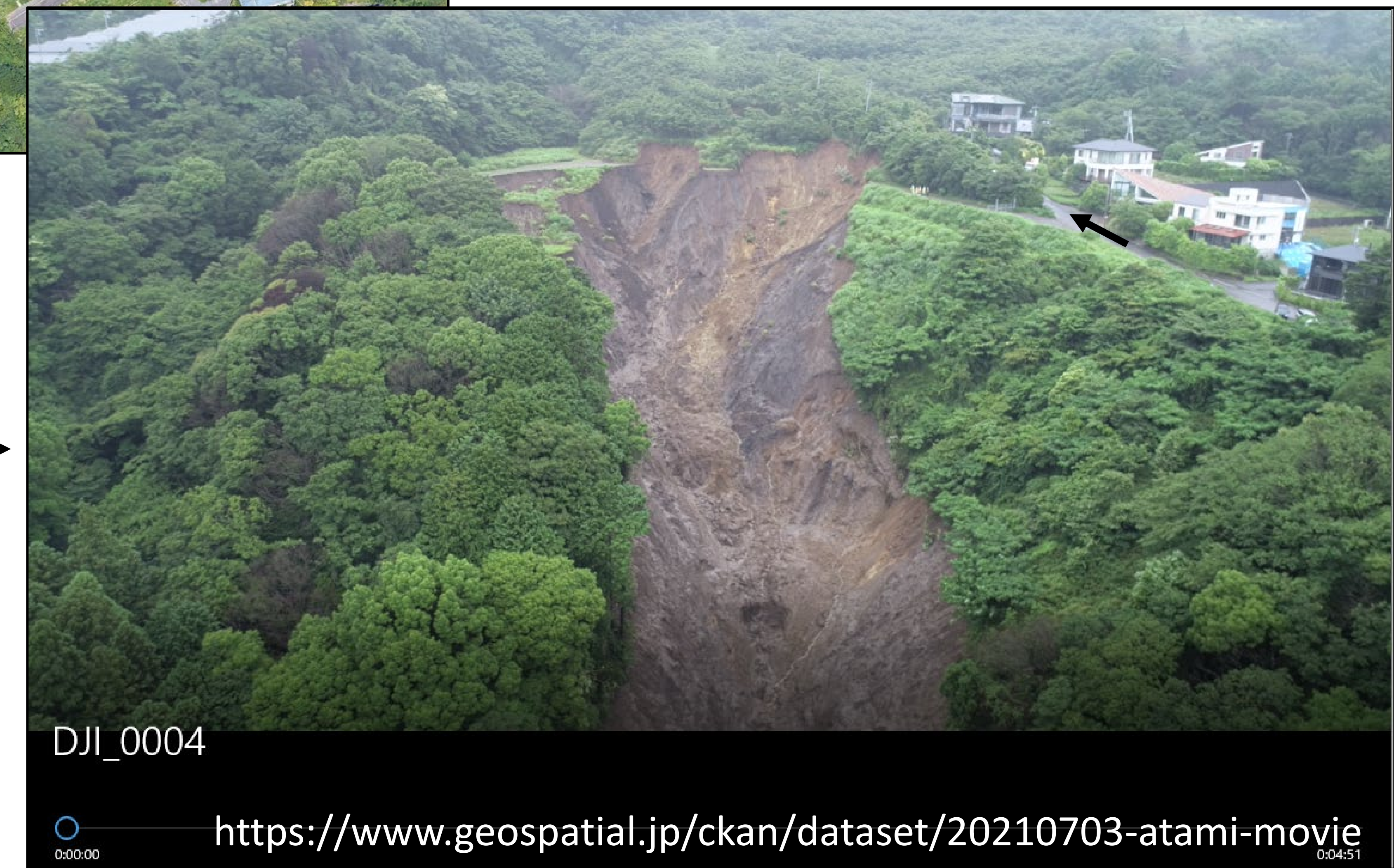
図4 静岡県が公開した土石流の原因と推定される崩壊地(35度7分18.82秒, 東経139度4分18.96秒, 標高は約390 m)のドローンで撮影した写真。
