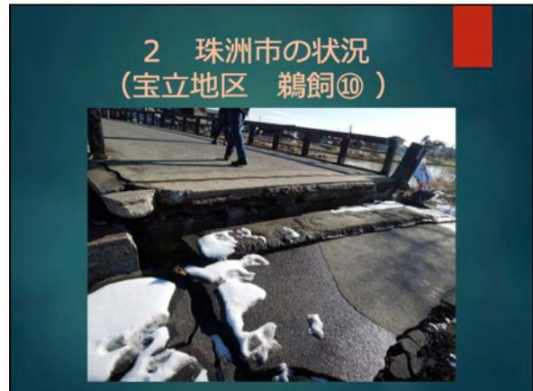
このような状況もよく見られたのですが、橋が架かっている橋自体は損傷がないのですけれども、兩岸の地盤沈下によって段差ができています。
