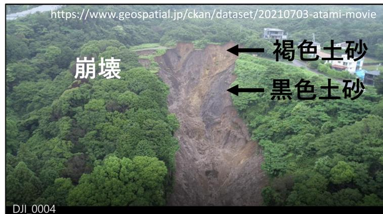
図4 静岡県が公開した盛土崩壊地の写真。盛土は、2011年までには崩壊前の状態になっており、推定崩壊量は約55,500m<sup>3</sup> (静岡県, 2021)
