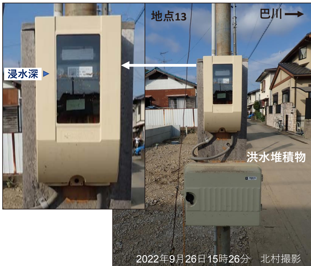
図15 地点3と13の状況.
