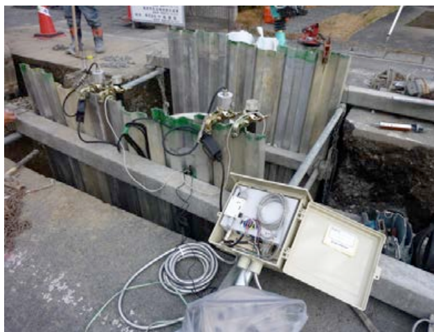
写真 2-3 土木工事現場の災害リスク早期警戒システム：試作品の現場検証
